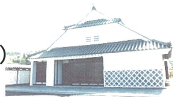
市重要文化財 旧石井家住宅
